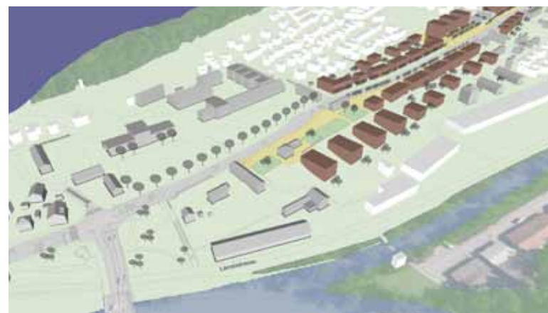
Gesamtübersicht Kaserne Richtung Norden
