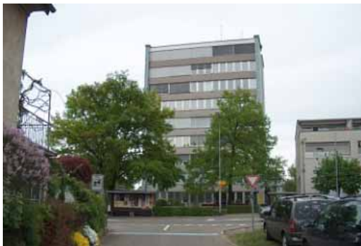
Abbildung 48: Gemeindefhaus Windisch (Quelle: www.bus-ab-brugg.ch )
